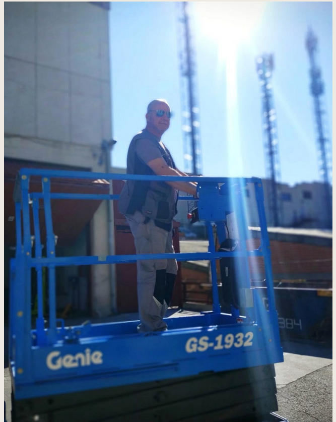
Presencia sobre el terreno y trabajos en altura.
