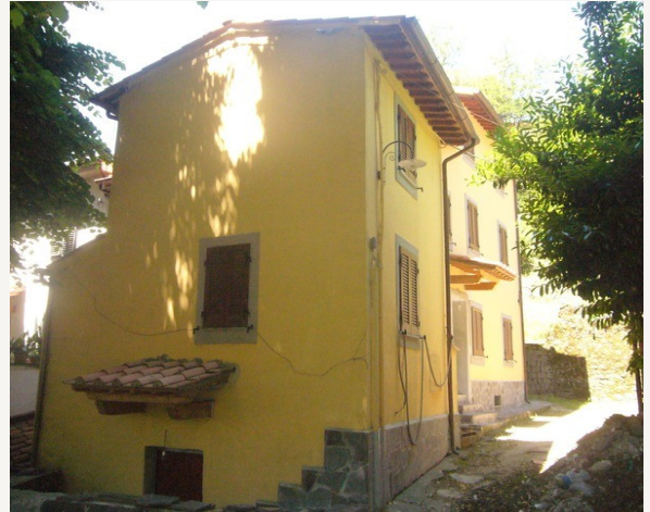
DESPUÉS • edificio reformado y terminado.
