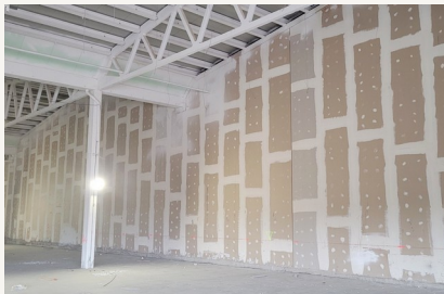
Obra: materiales, accesos, equipos y secuencias que coordinar.
