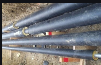
Redes térmicas / distribución.
