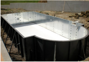
Vaso en fase de ejecución.
