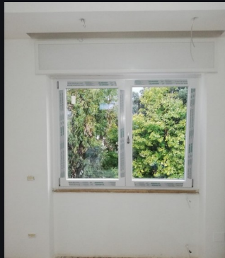
Cerramiento + pladur · integración de trabajos.
