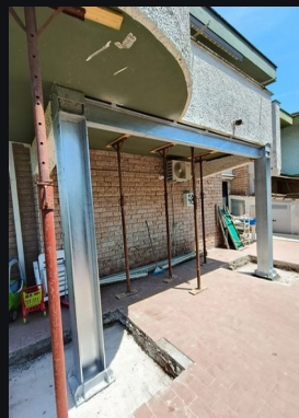
3 · Montaje de estructura.
