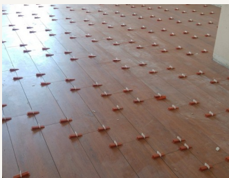
Colocación de pavimento.
