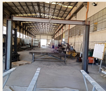
03 · Estructura en ejecución.
