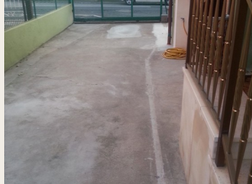
Pavimento exterior • antes.
