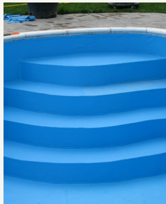
Escaleras y acabados.
