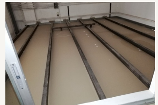
Estructura de falso techo y carpintería metálica.
