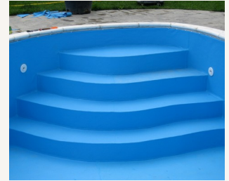
Detalle de escalera terminada.
