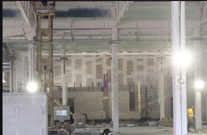
Gran superficie en fase de ejecución y coordinación.
