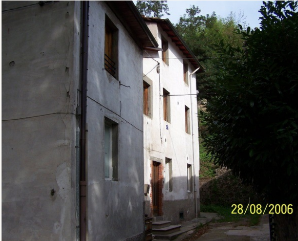
ANTES • edificio por reformar.
