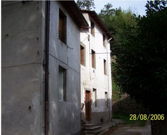
PRIMA • edificio da ristrutturare.
