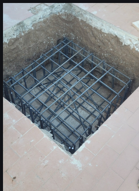
1 - Scavo e preparazione.
