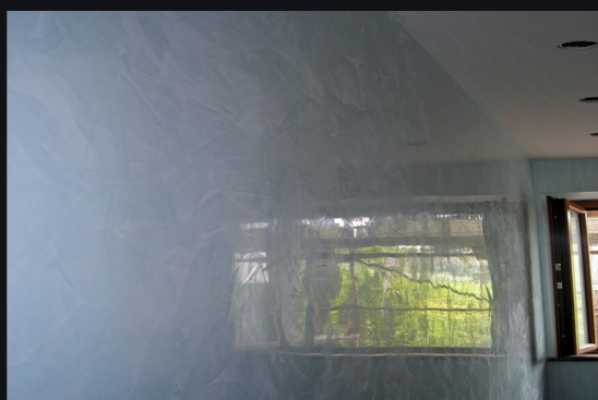
Stucco spatolato • finitura decorativa.
