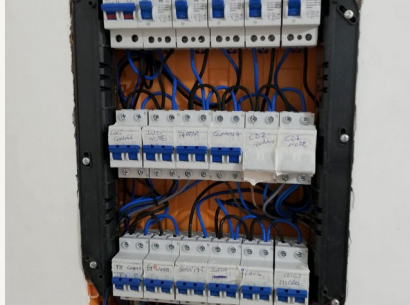
Quadro elettrico in fase di realizzazione.
