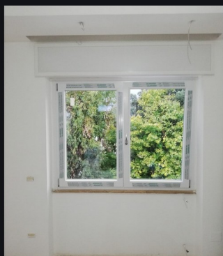
Serramento + cartongesso • integrazione lavori.
