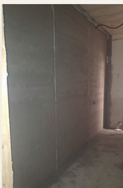
Preparazione superfici e supporti.
