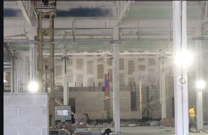
Grande superficie in fase di realizzazione e coordinamento.
