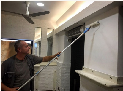
Presenza operativa quando è utile al risultato.
