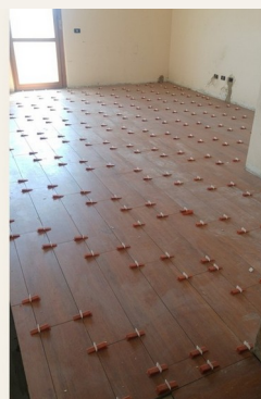
Posa pavimento - fase di lavoro.
