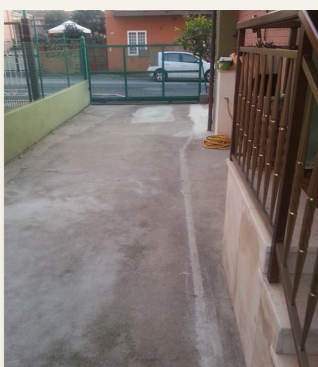
Pavimentazione esterna - prima.
